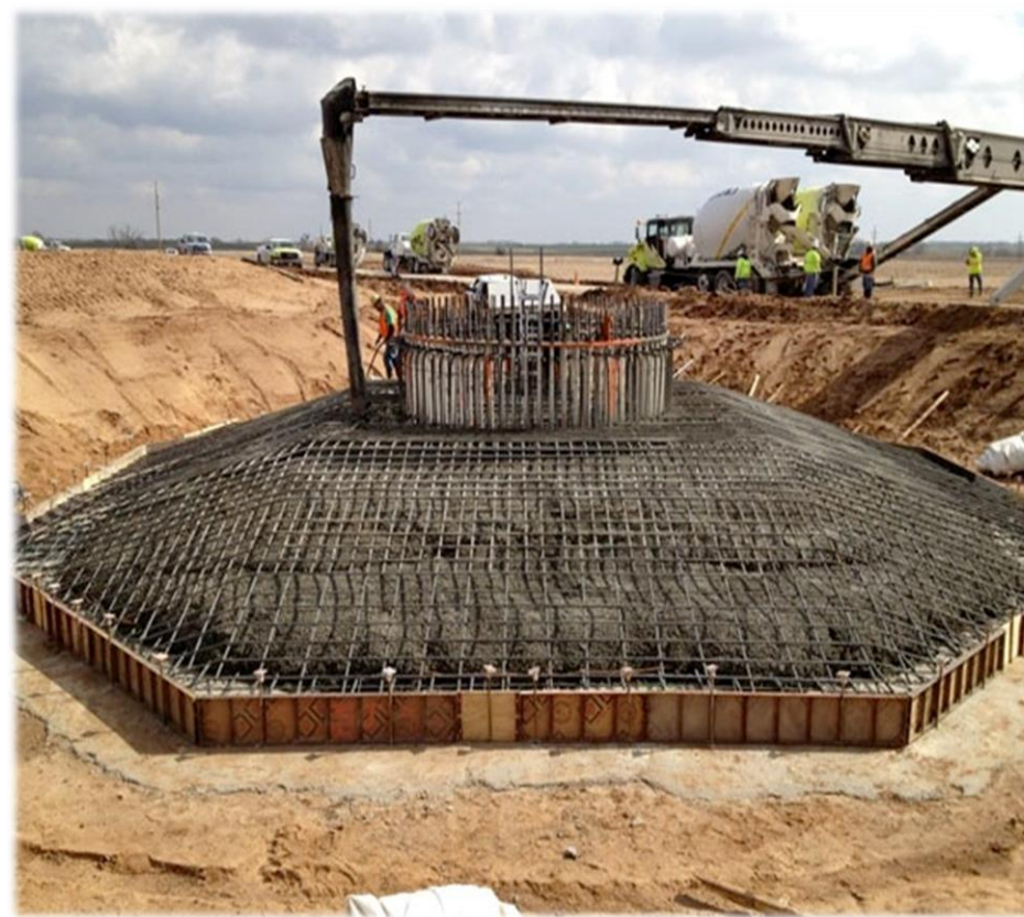
Obr. č. 5 : Teleso základov VtE z armovaného betónu
